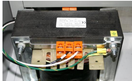
Transformateur soudure 400V Sec 75V No: 660-000011
