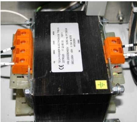
Transformateur d'isolement 400 V
